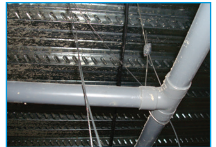
Condensate pipes
